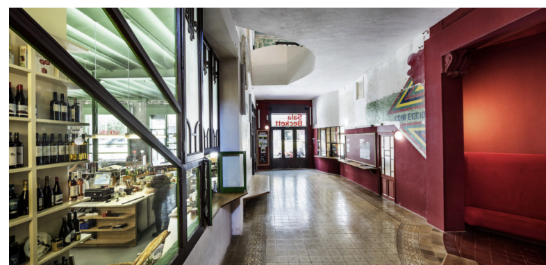
Alte Bauelemente wurden ausgebaut und an anderer Stelle wieder eingesetzt - wie dieses Fenster, das die Bar mit dem Foyer und dem Treppenraum verbindet
